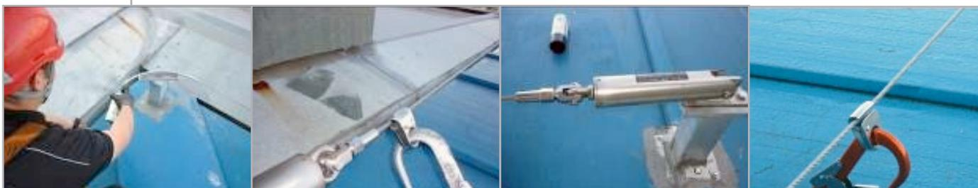
**Línea superior:** sobre soportes, con pasos intermedios, engastada en los extremos, con dos tensores y absorbedores en los extremos, con curvas y sobre techo, para **cuatro o más usuarios**.
