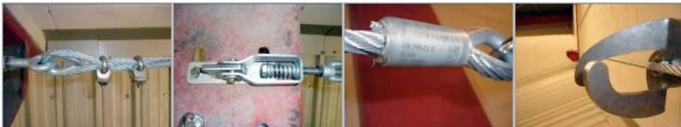
**Línea intermedia:** sobre soportes, con pasos intermedios, engastada en los extremos, tensor y absorbedor en los extremos, con curvas, para **tres o cuatro usuarios, pero uso limitado**.
