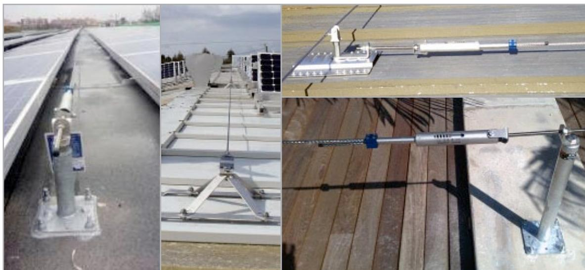
**Los tres modelos de línea se pueden instalar sobre cualquier tipo de cubierta**
