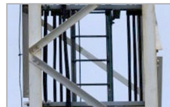
Detalle de la escalera instalada por el interior de la estructura de celosía de la torre
